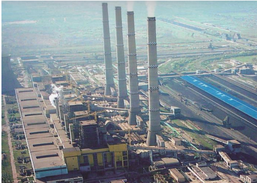
Figura 3. Termocentrala Turceni Sursa: Complexul Energetic Oltenia
